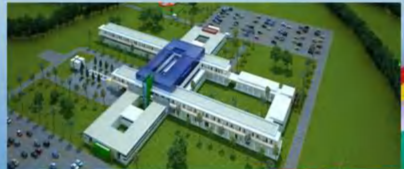
Hospital 3er nivel Trinidad
